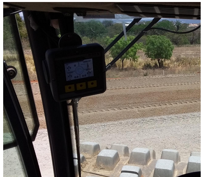
Obra de compactação no Ceará Foto: arquivo MOBA
