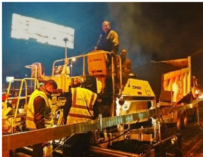
Nachtbaustelle Kairoer Stadtautobahn
